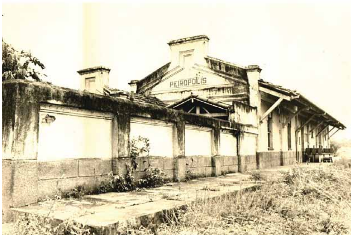
Figura 47 Estação Ferroviária de Peirópolis na década de 1980.
