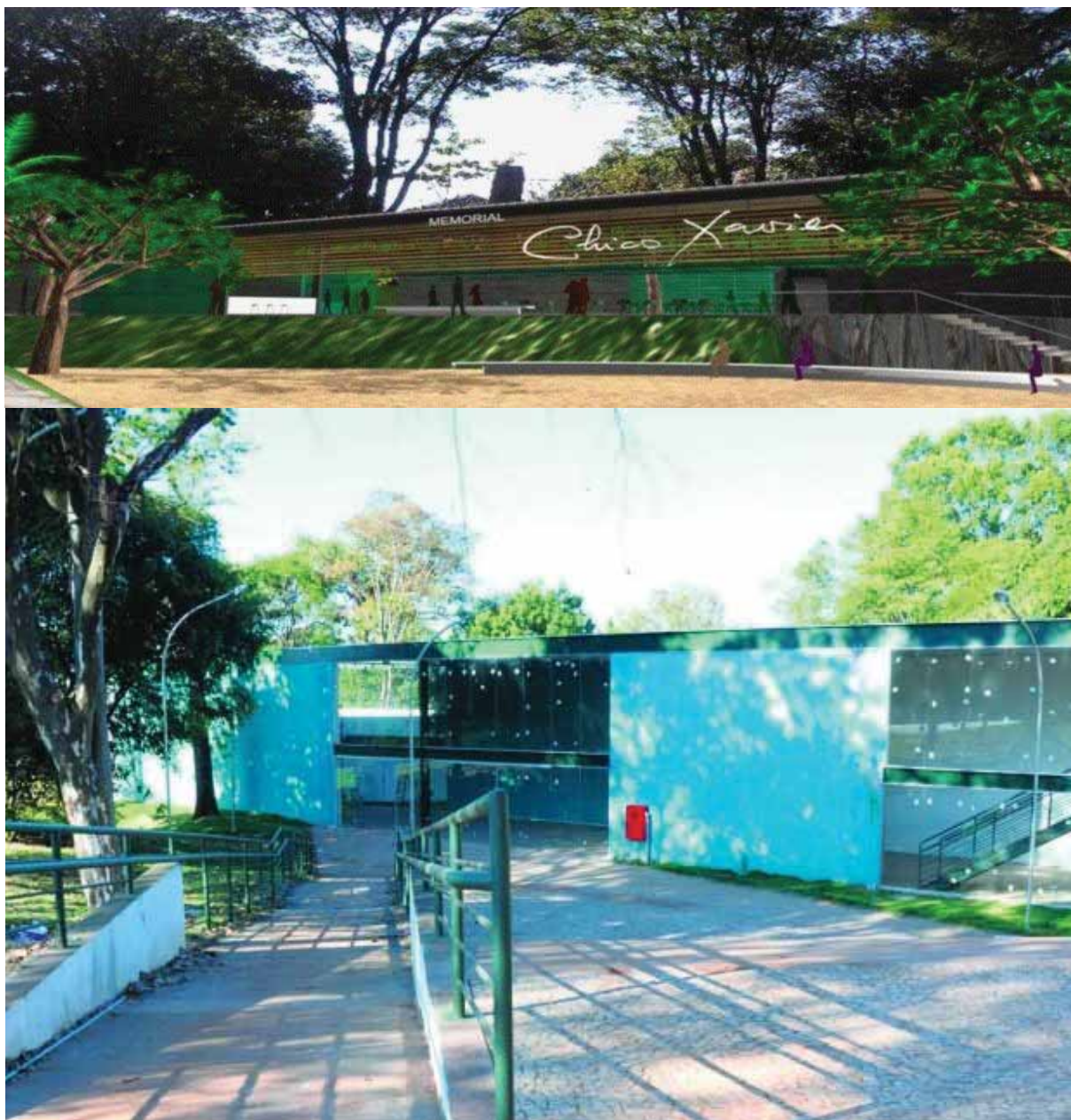
Figura 39 Maquete digital acima e obras do Memorial Chico Xavier abaixo.
