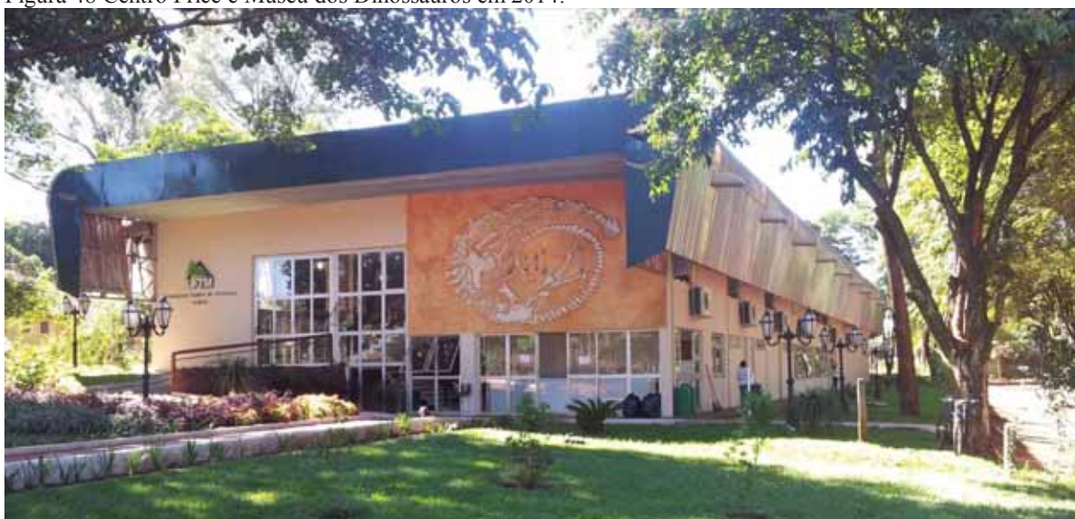
Figura 49 Fachada principal da sede do CCCP/UFTM.
